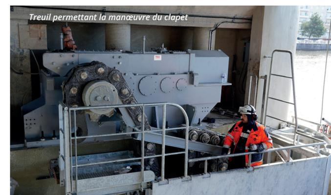
Treuil permettant la manœuvre du clapet
