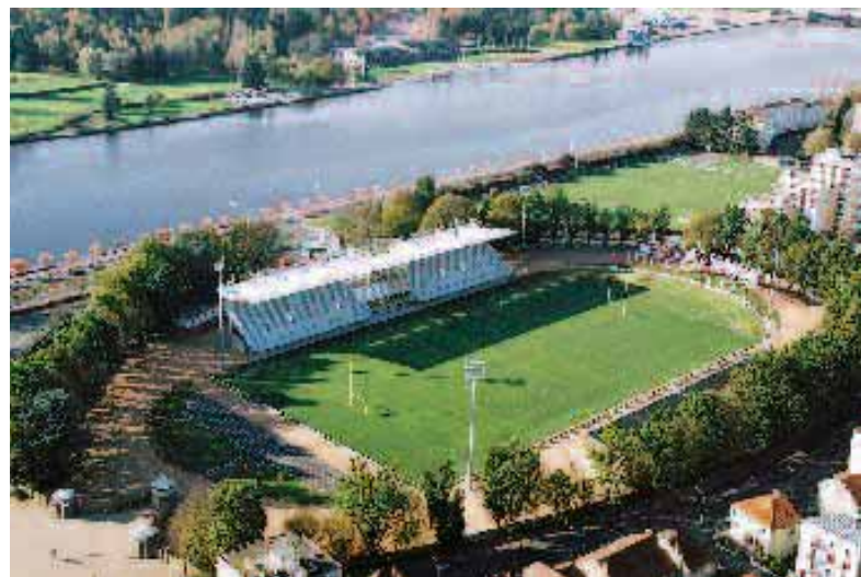
LE STADE DARRAGON A ÉTÉ RÉCEMMENT RÉAMÉNAGÉ EN PRÉVISION DE L'ÉVÉNEMENT ET POURRA ACCUEILLIR 4644 SPECTATEURS
