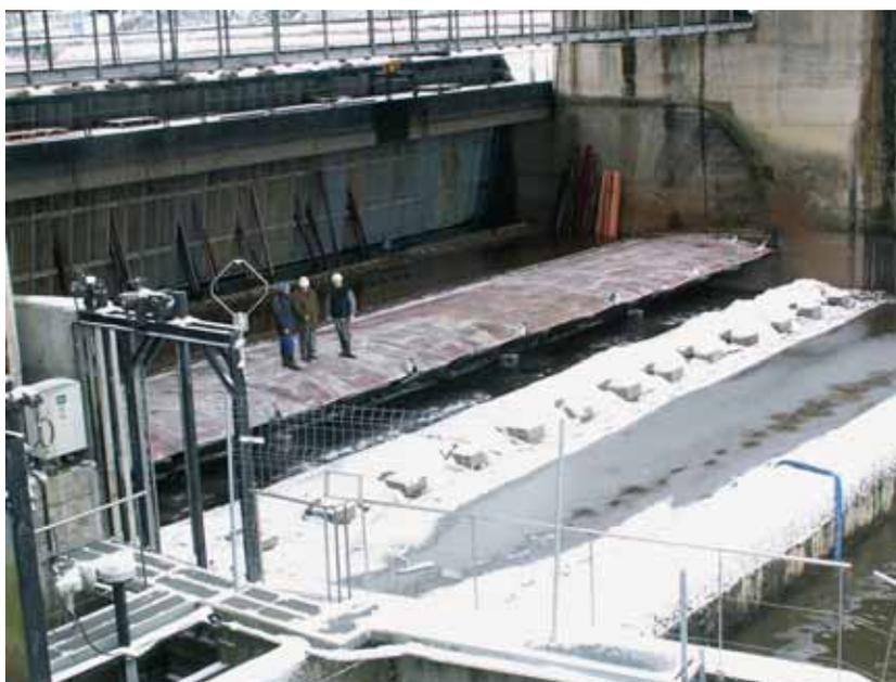
**SEPT VANNES-CLAPETS, CHACUNE D'UNE SUPERFICIE DE 122 M<sup>2</sup> ET D'UN POIDS DE 40 TONNES RETIENNENT LES 2,5 MILLIONS DE M<sup>3</sup> D'EAU DU PLAN D'EAU.**
