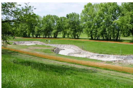
**La Ville de Vichy a lancé**, il y a quelques semaines, **les travaux de rénovation et d'amélioration** : les enrochements et les bétons du radier et des rives seront repris et consolidés, deux embarcadères seront créés sur le parcours et la mise à l'eau du bassin de départ et du débarcadère du bassin d'arrivée sera modifiée.
