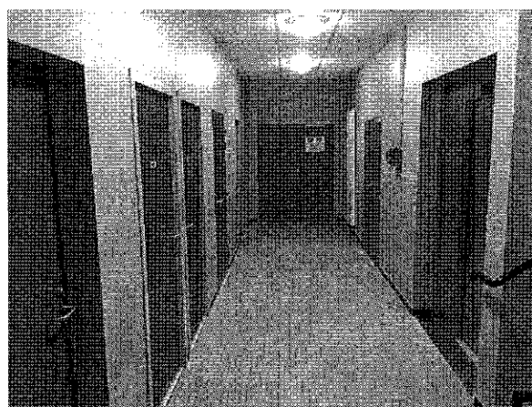
Intérieur d'un vestiaire sanitaire
