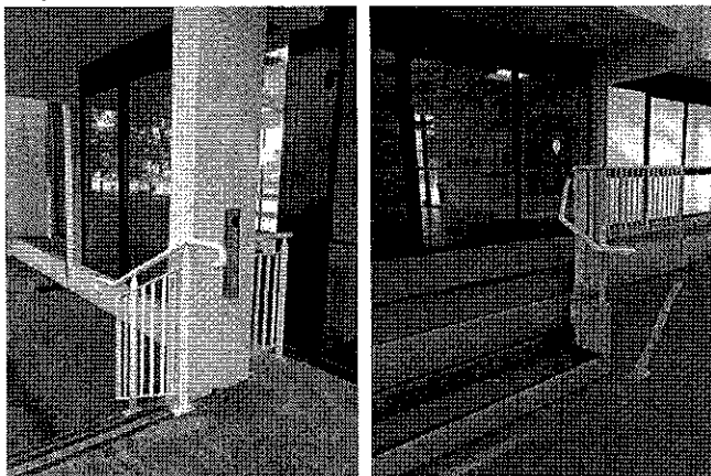
Mains courantes escaliers extérieurs
