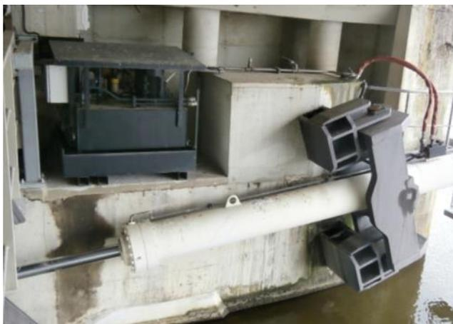
**Figure 1: Système actuel de manœuvre du clapet N°2 (vérin hydraulique)**
