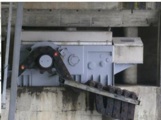
**Figure 2: Ancien système de manœuvre du clapet N°2 (réducteur et chaîne Galle)**
