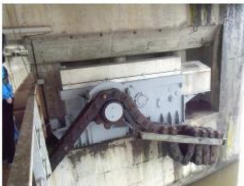
Il convient de concevoir un dispositif de protection de la chaîne simple, robuste et efficace.
