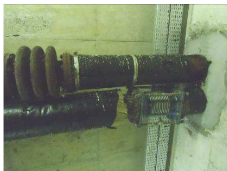
Photo 11 - Conduite dans culée CO côté terre-plein
