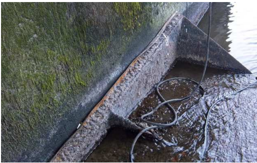
Photo 3 - Vue du joint d'étanchéité latérale gauche du clapet n°5
