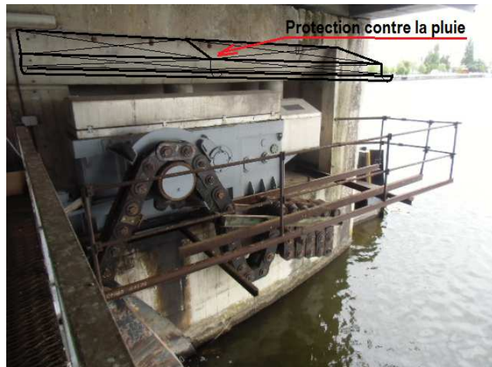
Photo 6 - On voit que la chaîne Galle de la passe N°4 est couverte de fientes et que la graisse a disparu.
