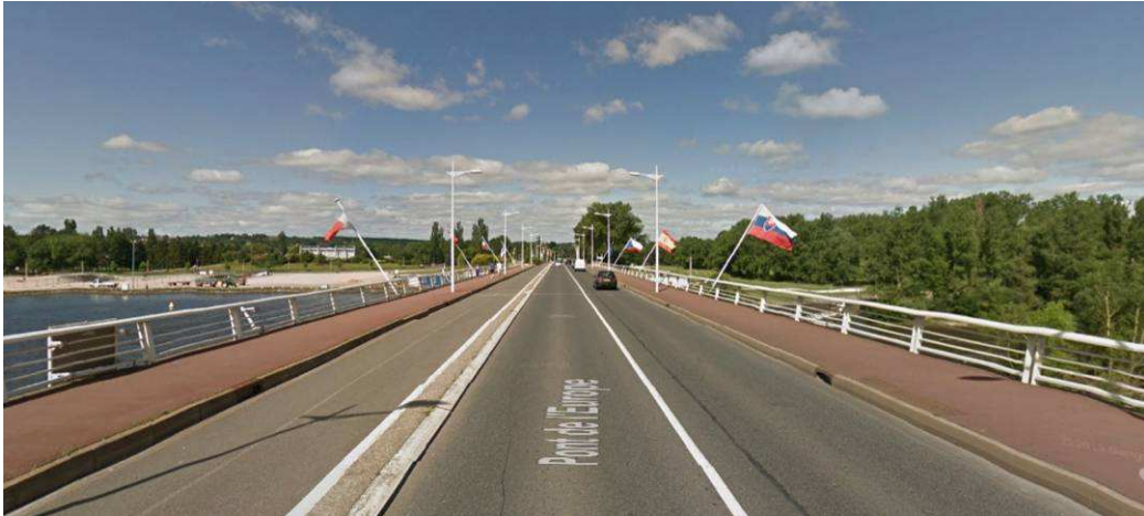
Vue sur la voirie supportée par le pont-barrage
