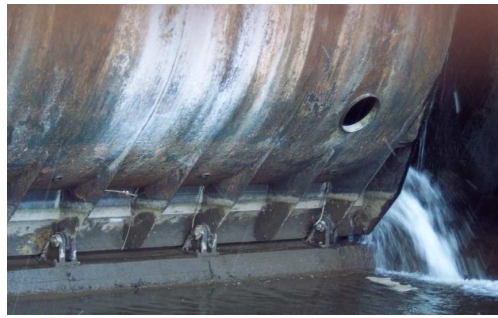
Photo 4 - Vue des paliers du clapet n°4
