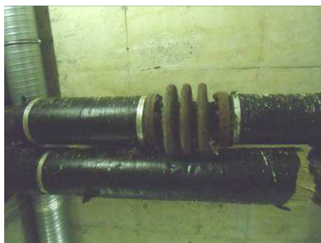
Photo 10 - Conduite dans culée CO côté passe
