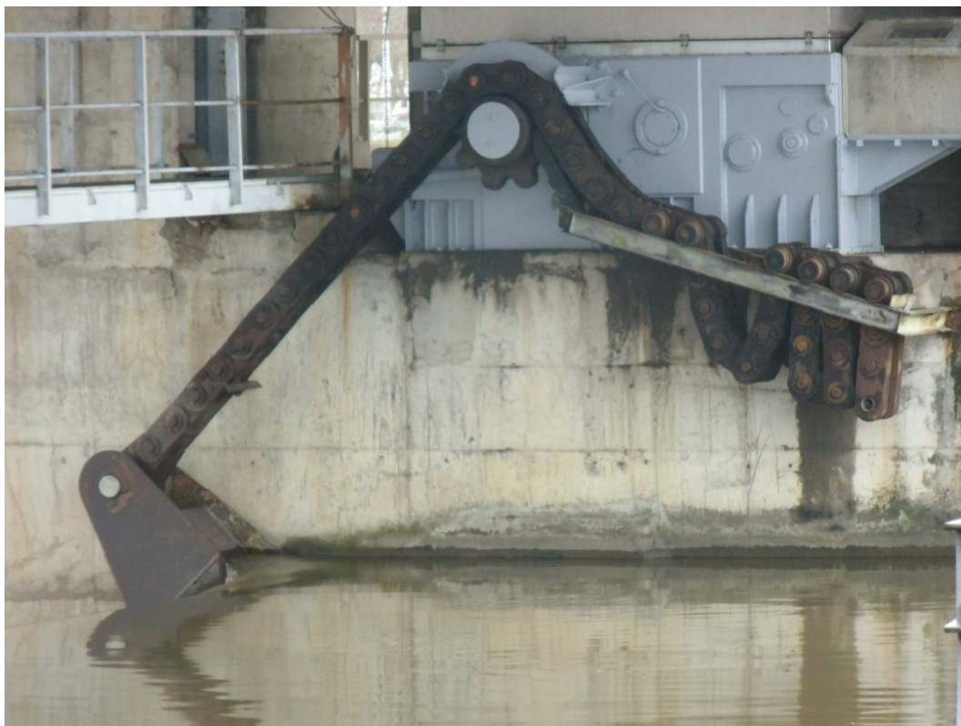
Relevage des clapets par treuil motorisé
