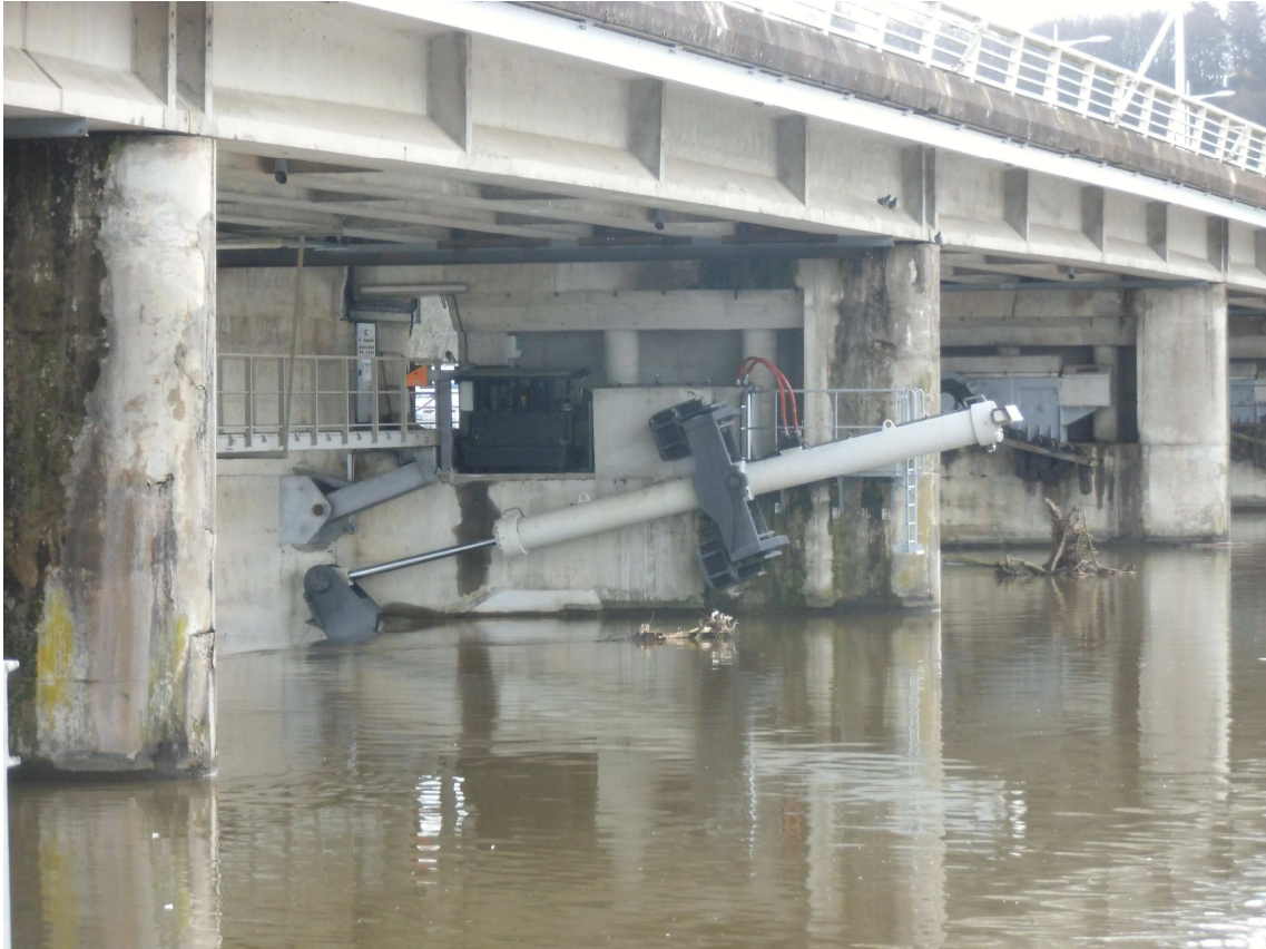
Relevage du clapet N°2 par vérin hydraulique
