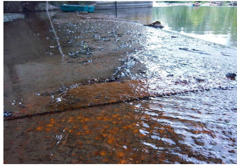
Photo 2 - Bordé amont du clapet n°5
