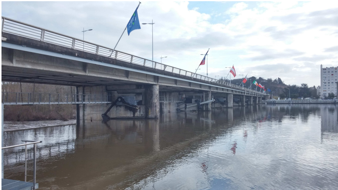
Vue d'ensemble du pont-barrage
