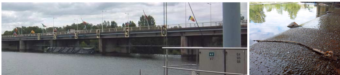
Photo 7 - Les positions des lignes d'eau sont repérées par des numéros disposés sur les travées 4 à 6 du tablier du pont. Les lignes sont accrochées aux clapets par des élingues (ici élingue sur le clapet n°5).
