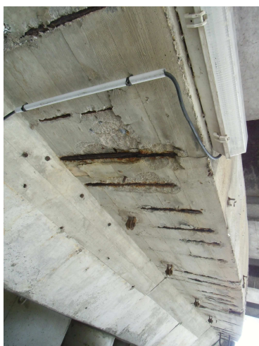
Photo 8 - Fers apparents sous chevêtre d'appui routier de pile
