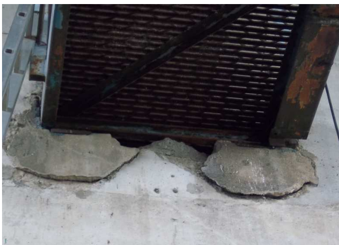
Photo 9 - Béton éclaté sous appuis passerelle
