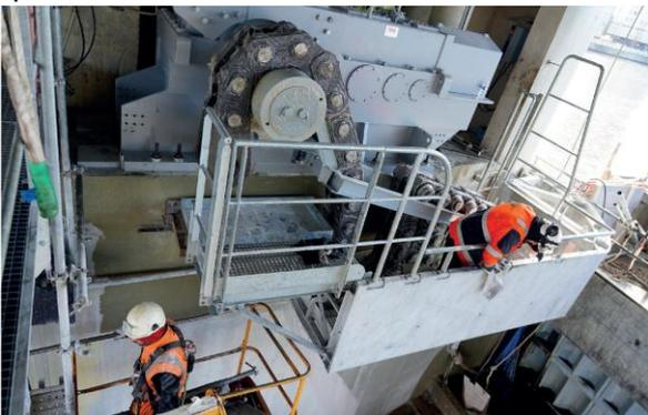
Chaque clapet est actionné par un système de treuil et de chaîne galle
