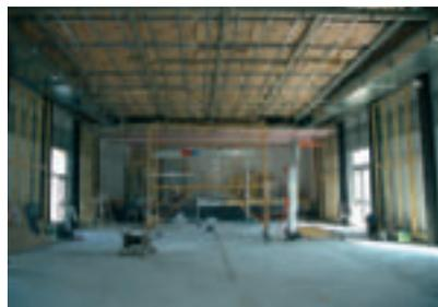
meilleure isolation acoustique et thermique. Étape suivante, l'isolation et la pose du faux-plafond et la mise en place des éclairages et du chauffage. Les travaux se termineront début juin.
