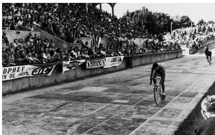
Stade Municipal L. Darragon - Passage du Tour de France
