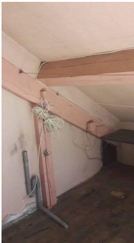
Demi-ferme porteuse du solivage du dernier niveau
