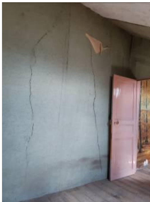
Nombreuses fissures dans murs des combles
