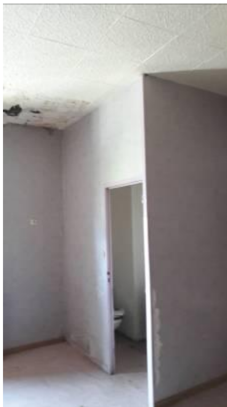
Infiltration d'eau en plancher haut R+2
