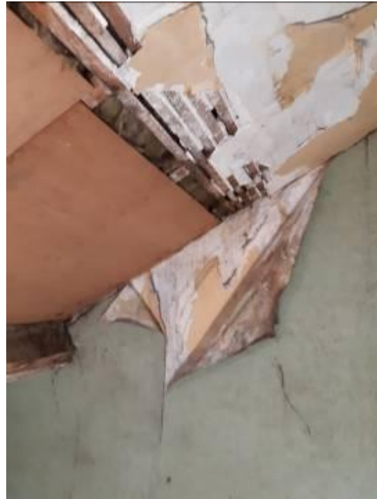
Infiltrations d'eau et lattis endommagés
