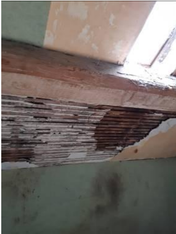
Infiltrations d'eau et lattis endommagés
